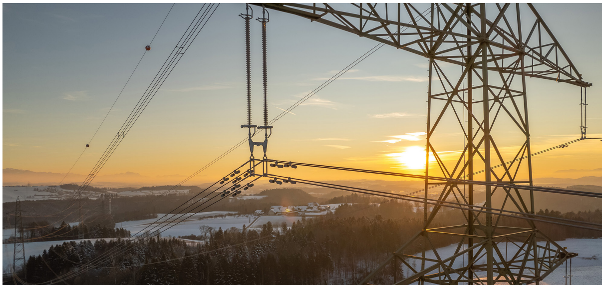
La linea Bassecourt – Mühleberg attraversa per 45 chilometri i Cantoni del Giura e di Berna. Fin dal 1978 la tensione della linea è stata di 220 kV; alla fine di novembre 2023 è passata a 380 kV, in modo da garantire una migliore sicurezza della rete e dell'approvvigionamento elettrico in Svizzera.
