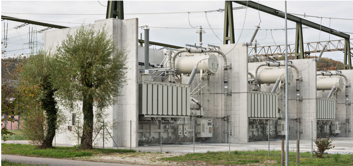
Les transformateurs jouent un rôle essentiel pour l'augmentation des importations d'électricité en Suisse. Ils permettent de coupler le réseau de transport européen de 380 kilovolt au réseau de transport suisse de 220 kilovolt. On voit ici le transformateur-déphaseur de la sous-station de Beznau.
