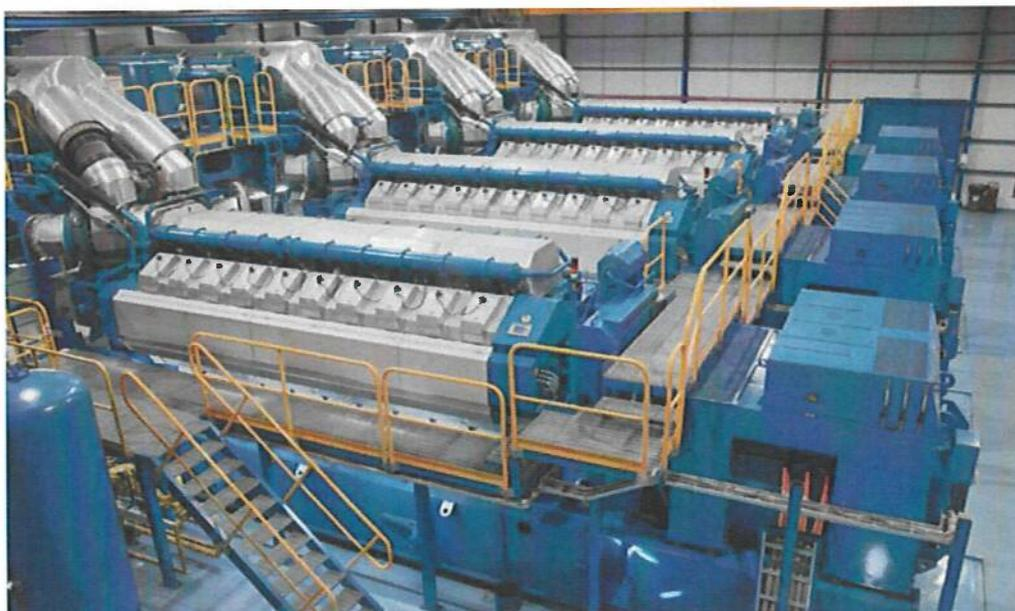
Abbildung 3-2 Gasmotorenkraftwerk (Quelle: Wärtsilä)
