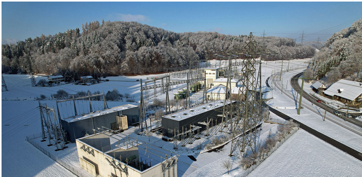
La sous-station de Bickigen à Wynigen est l'une des plus grandes plaques tournantes de l'électricité de Suisse. L'énergie électrique y est transformée et injectée dans les réseaux de distribution régionaux et suprarégionaux.
