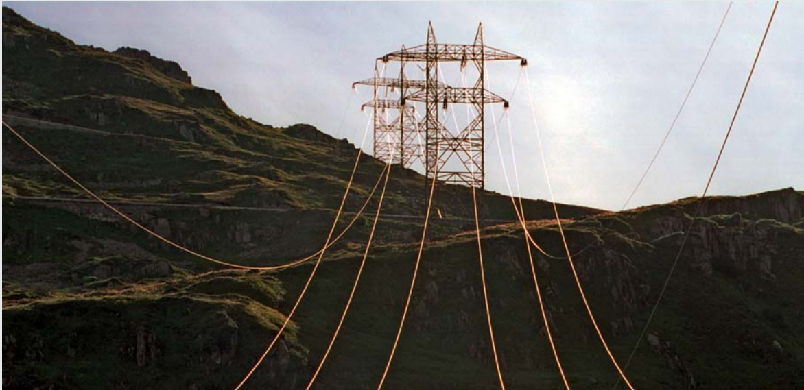
Ligne à haute tension au col du Nufenen.
