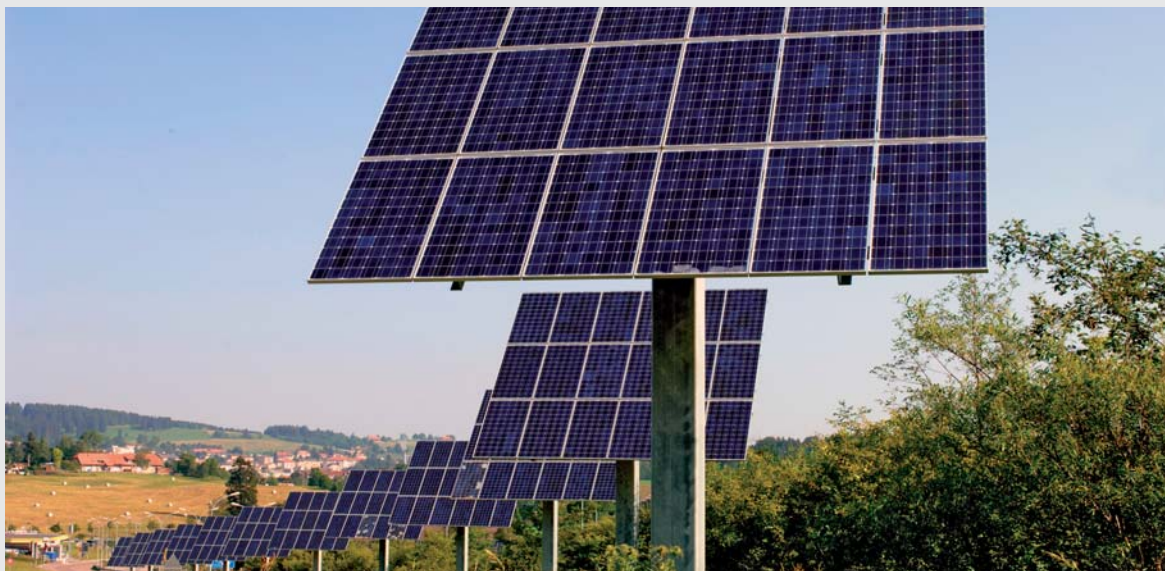
Solarmodule einer grossen Sonnenenergieanlage in La Chaux-de-Fonds.
