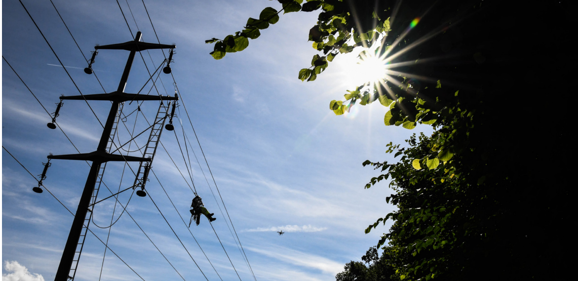
Etwas über 6'600 km lang ist das Hochspannungsnetz der Schweiz. Im Bild ein Freileitungsmonteur oberhalb des Walensees.
