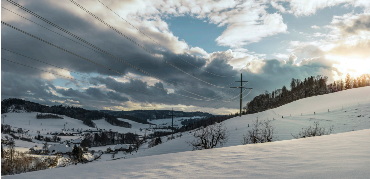
Rund 640 Netzbetreiber unterhalten das Schweizer Stromnetz. Im Bild eine Mittelspannungsleitung im bernischen Simmental.
