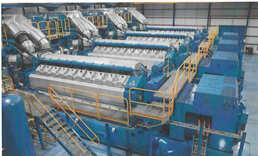
Abbildung 3-2 Gasmotorenkraftwerk (Quelle: Wärtsilä)
