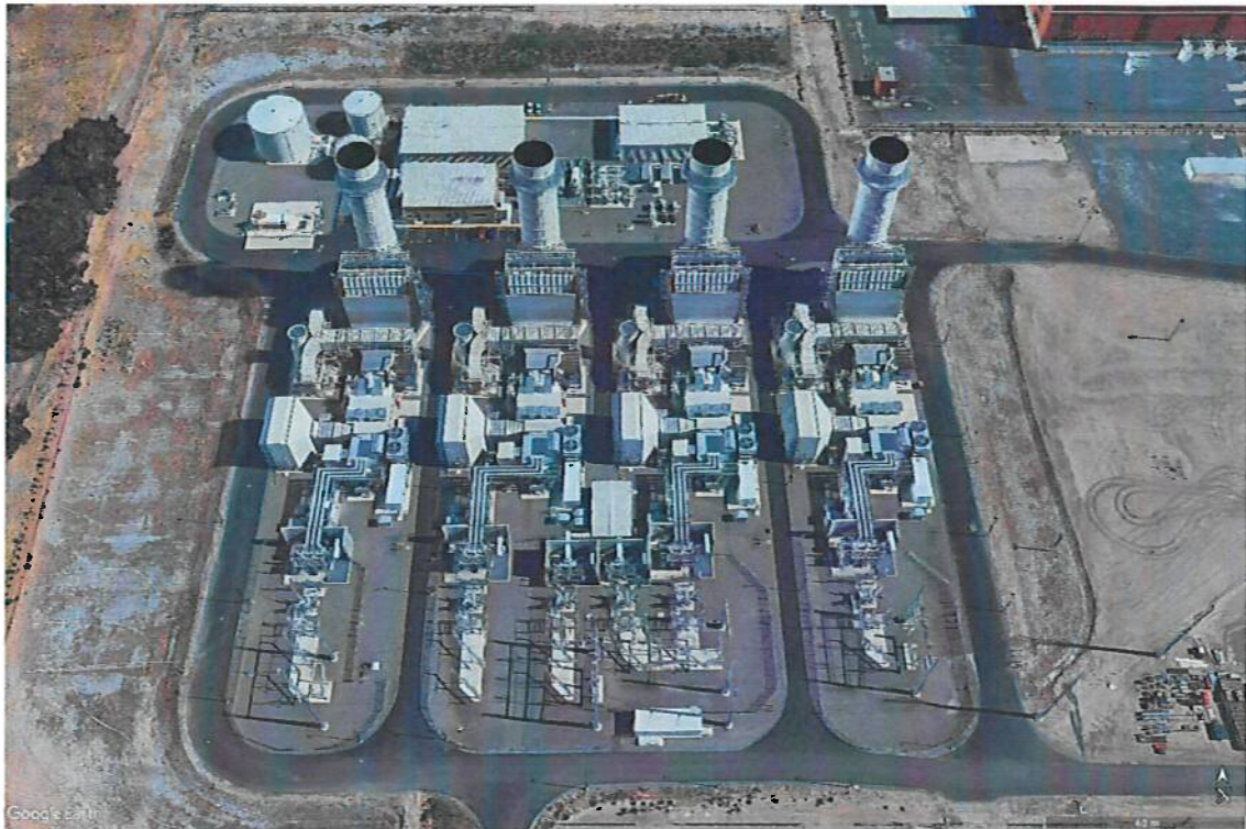
Abbildung 4-2 750 MW Gasturbinenkraftwerk mit SCR (NRG Marsh Landing, USA)
