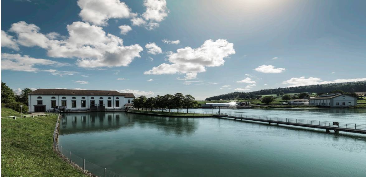
Wasserkraftwerke liefern einen wichtigen Teil an die Stromversorgung der Schweiz. Im Bild das Laufwasserkraftwerk Wynau.
